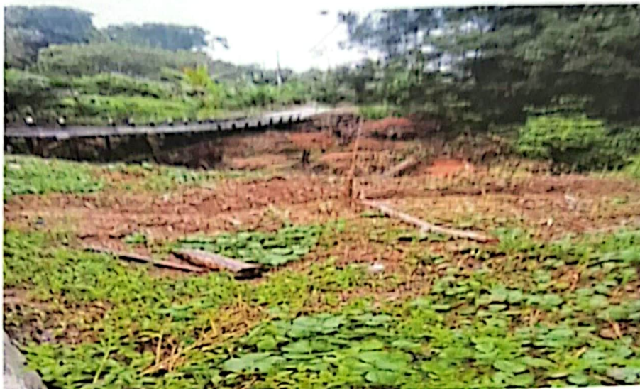
Pembangunan Jembatan Belah Labah RT.07 / Dusun Lempah Restu ( 29 x 3 m ) 2025.
